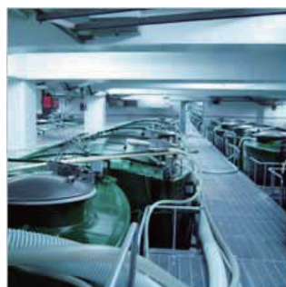
工場内のタンク
